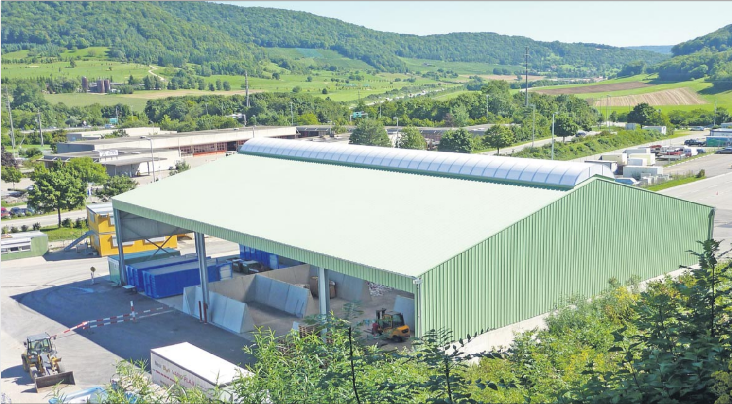
In der neuen Halle mit einer Fläche von 1200 Quadratmetern ist der neue Entsorgungspark des Re-Center-Fricktal in Frick eingerichtet worden.
