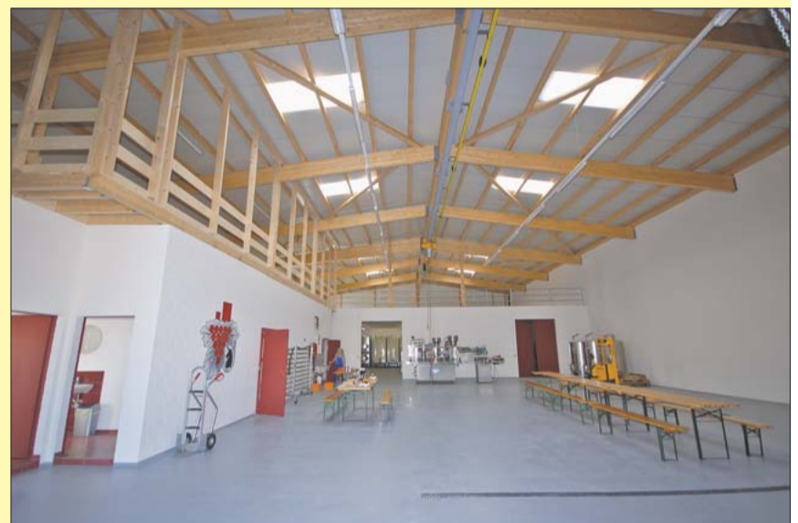
Beeindruckend: Der grosse Mehrzweckraum im neuen Weinkeller; hinten Tank- und Flaschenlager, links die Nebenräume
